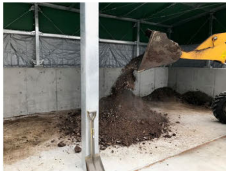
重機による切返し状況
