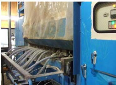
5 スラッジ水を脱水機へ
