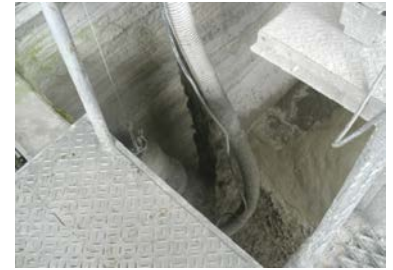
4 残ったスラッジ水を水槽へ
