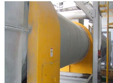
7 スラッジケーキを破碎乾燥機へ
