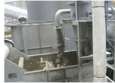
3 スラッジ中の微砂分を除去
