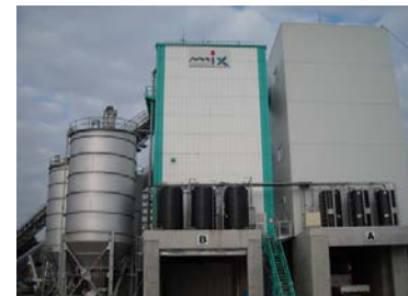
10 生コンプラントにてエコクリートR 3 製造
