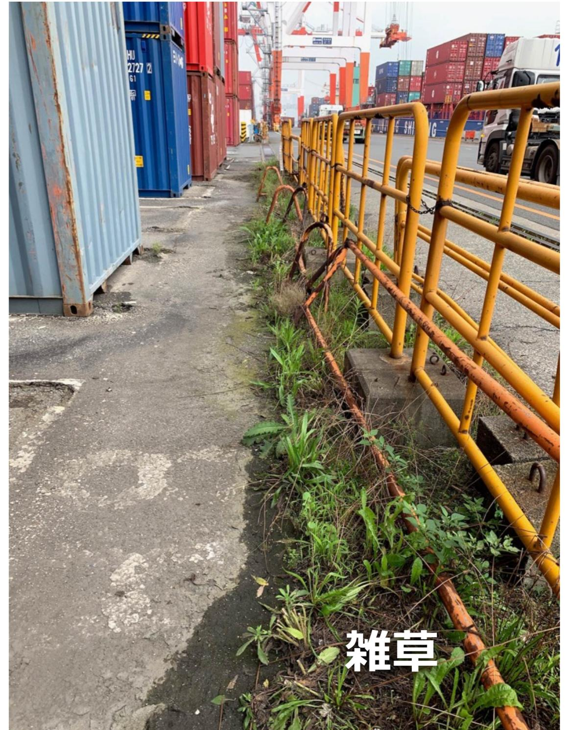
**364日・24時間稼働している主要港湾のコンテナヤードでは、大規模な補修工事は不可能で、舗装面に経年劣化が生じている**
