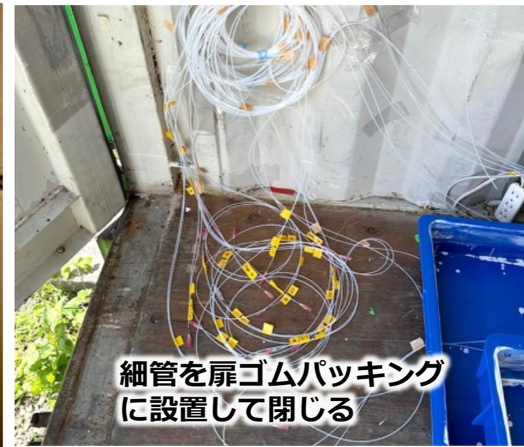
細管を扉ゴムパッキングに設置して閉じる
