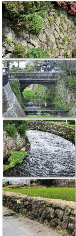
阿蘇地域に無数に存在する地元の石材を用いた石積み構造物
