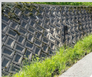
コンクリート ブロック擁壁
