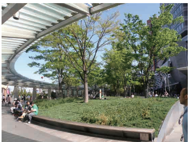
六本木ヒルズ：人工地盤の「66 プラザ」と地上45mの屋上を緑化。最大1mの植栽基盤を整備しケヤキなどを植栽。 (東京都港区六本木)
