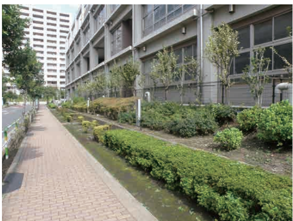
荒川区立荒川第三中学校：道路側に傾斜したマウンドを形成し、奥に中木の生垣、手前に多様な低木を植栽し修景。（東京都荒川区南千住）
