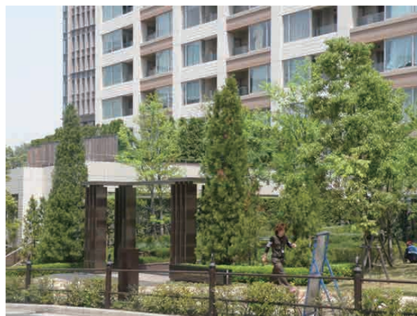
パークコート赤坂 ザタワー：3階の低層階屋上をプライベートガーデンとして屋上緑化している。 (東京都港区赤坂)
