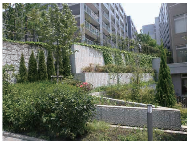
渋谷区立中央図書館：公共施設での狭隘な空間を活用した緑化事例。（東京都渋谷区神宮前）
