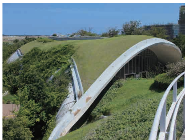
アイランドシティ中央公園「ぐりんぐりん」：地上と一体となった連続した屋上空間を創出。（福岡県福岡市東区）
