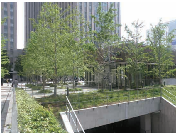
霞ヶ関ビル地下駐車場：地下駐車場の上の人工地盤に高木を植栽している。 (東京都千代田区霞ヶ関)
