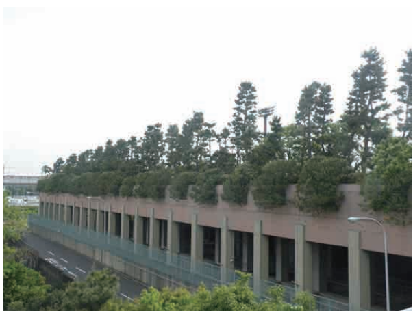
葛西水再生センター下水処理場 江戸川区球技場：水処理施設上の人工地盤を活用した江戸川区の球技場を緑化。（東京都江戸川区臨海町）
