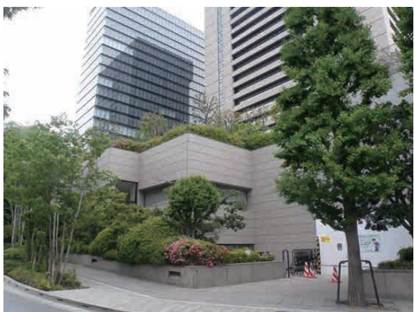
三井住友海上駿河台ビル：1984年3月に整備した先駆的な屋上庭園。地域の環境改善や景観形成に貢献。 (東京都千代田区神田駿河台)
