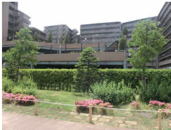
オーチャードプラザ & オーバルグランディオ 隣接する集合住宅高層棟に囲まれた中庭の駐車場を立体化し、コミュニティスペースを創出。 (神奈川県川崎市幸区)
