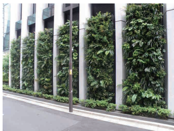
住友商事神田錦町ビル 建物周辺の狭隘な路地を利用して壁面緑化。テイカカズラ、シダ類等の多様な植物を導入。 (東京都千代田区神田錦町)
