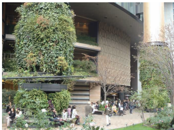
丸の内パークビルディング三菱 1 号館 タワー塔の大きな三つの円柱にカセット型緑化ユニットを導入し高さ 10m 程度まで緑化。 (東京都千代田区丸の内)
