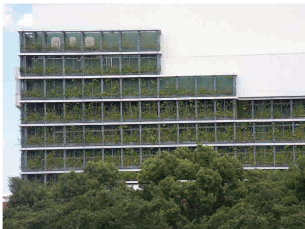
板橋清掃工場 緑化パネルはステンレス製メッシュと植栽コンテナを一体化し、格子状フレームにはめ込む。 (東京都板橋区高島平)
