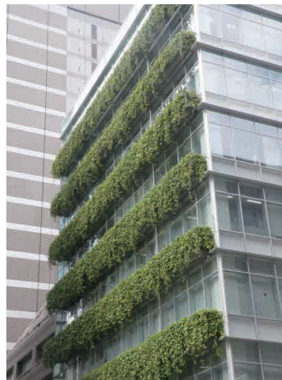
品川サンケイビル 賃貸オフィスビルの2～8階の西向き壁面を緑化。コンテナユニットを各階に設置し、室内からも緑が楽しめる構造。 (東京都港区港南)
