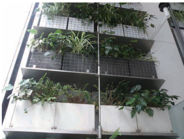
銀座ニコラス・G・ハイクセンター プランターと灌水設備と登はん補助資材。 (東京都中央区銀座)
