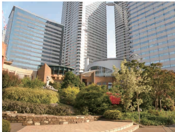
晴海アイランド トリトンスクエア 商業施設としてのグレードアップと集客力向上を目指して花を中心とした緑地空間を創出。 (東京都中央区晴海)
