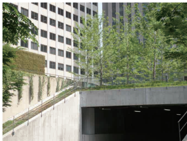
霞ヶ関ビル 地下駐車場 地下駐車場の上の人工地盤に高木樹種のイチョウを植栽している。土壌厚は1mに満たない。 (東京都千代田霞ヶ関)
