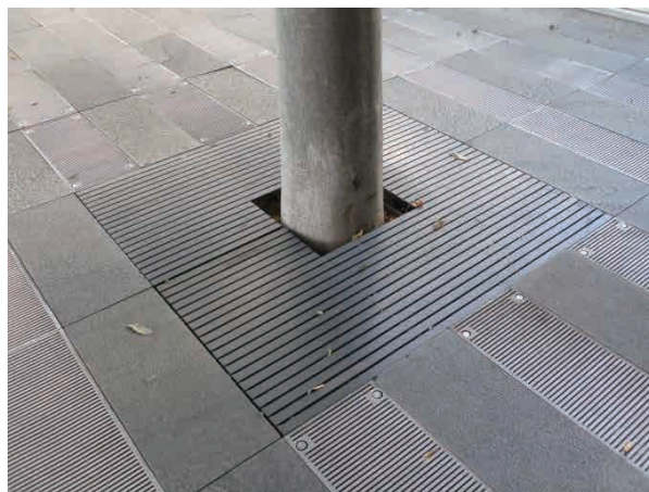
グレーチングによる根際部の養生 (さいたま新都心ケヤキ広場 (埼玉県さいたま市大宮区))
