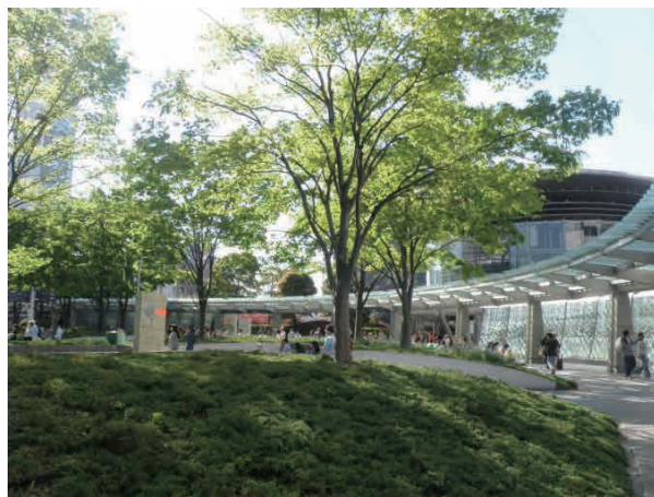
六本木ヒルズ 人工地盤「66 プラザ」と地上 45m の「グリーンマスダンパー」の人工地盤を緑化し整備。 (東京都港区六本木)
