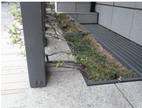
経団連会館 狭隘な場所での植栽基盤整備。 (東京都千代田区大手町)
