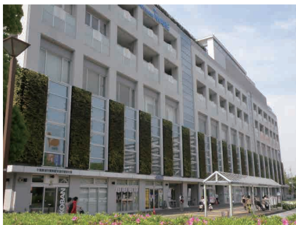
JR 新浦安駅前プラザマーレ 壁面緑化 駅前の複合商業施設の壁面に生育基盤や登はん補助資材を設置しヘデラ類で壁面緑化。 (千葉県浦安市入船)
