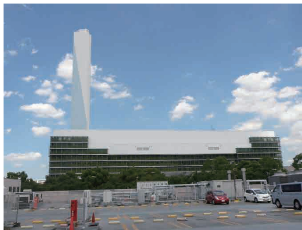
板橋清掃工場 清掃工場の躯体の外壁をユニット化した緑化パネルで緑化。ヘデラ・カナリエンシス、ムベなど。 (東京都板橋区高島平)
