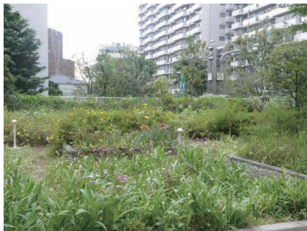
サンスクエア川崎 駐車场上人工地盤 集合住宅団地の駐車場の人工地盤を樹木や花壇 により明るく親しみやすい緑地空間を創出。 (神奈川県川崎市日新町)
