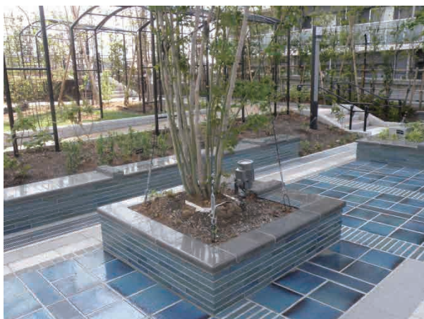
ワイヤー支柱 人工軽量土壌のため通常の支柱が効かないため植 根に金具で固定している。 (東京都世田谷区大橋)
