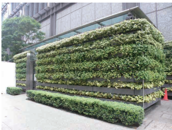
新丸ビル 駐輪場 プランターを積み重ねヘデラ類などを導入。 (東京都千代田区丸の内)
