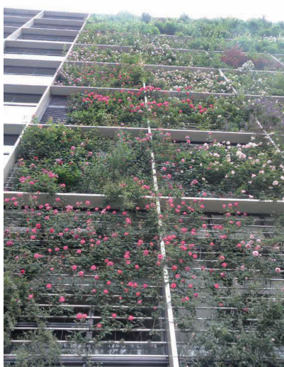
パナソニックグループ本部 バルコニーにプランターを設置し、外壁フェンスにツルバラなどで緑化している。 (東京都千代田区大手町)
