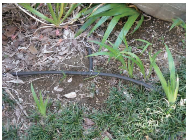
点滴式の灌水チューブ (御殿山プロジェクト (東京都品川区北品川))
