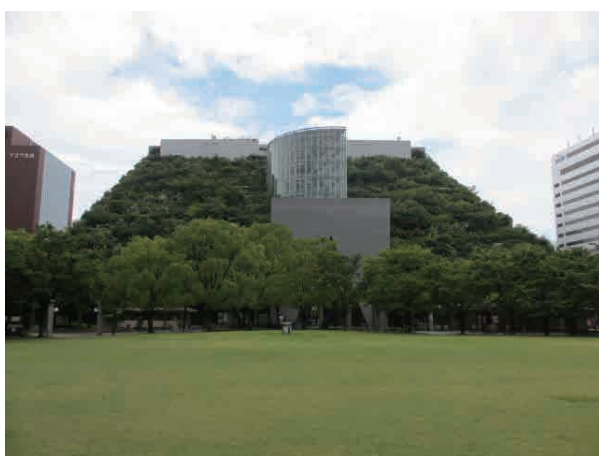
アクロス福岡 ステップガーデン 隣接する天神中央公園との一体化を意図した屋上緑化で、面積 5,400m 2 とわが国最大規模。 (福岡県福岡市中央区天神)
