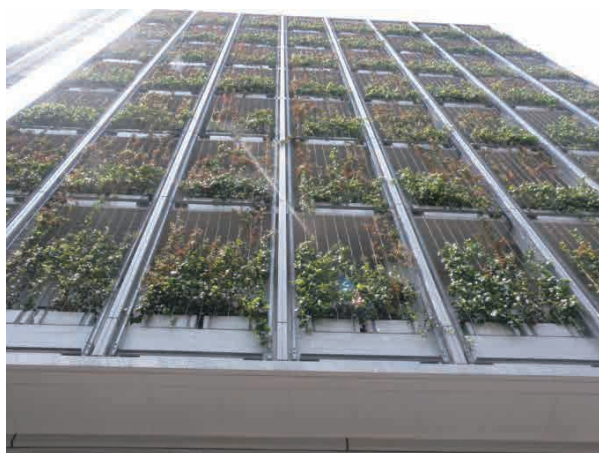
原宿警察署 警察署建物の三面にプランターと誘引格子を設置し、ヘデラ類を導入して壁面緑化を行っている。 (東京都渋谷区神宮前)
