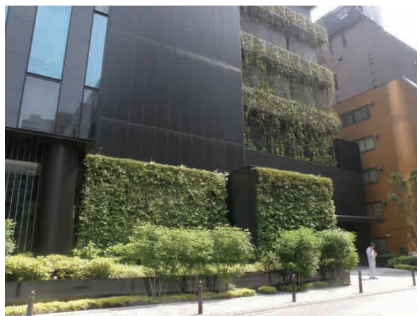
虎ノ門ファーストガーデン 壁面緑化 プランター一体型緑化システムと登はん補助資材を導入しツル植物で9階までの壁面を緑化。 (東京都港区虎ノ門)
