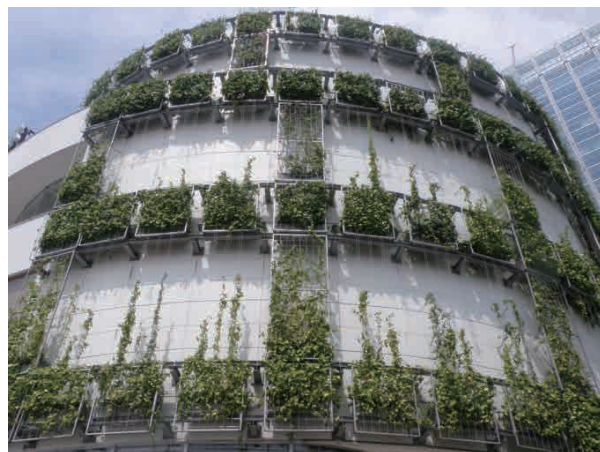
横浜ベイクォーター 壁面にコンテナユニットと格子状の登はん補助資材を設置しヘデラ類などで壁面緑化。 (横浜市神奈川区)
