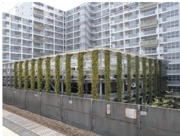
JR 潮見駅前プラザ二番街駐車場 駐車場の上にプランターを設置し、下垂性のカラライナジャスミンを垂らして壁面緑化。 (東京都江東区潮見)
