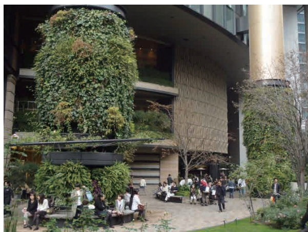
丸の内パークビルディング 三菱1号館 ビルの中庭と低階層屋上を緑化。タワー塔の円柱をカセット型緑化ユニットによる壁面緑化。 (東京都千代田区丸の内)
