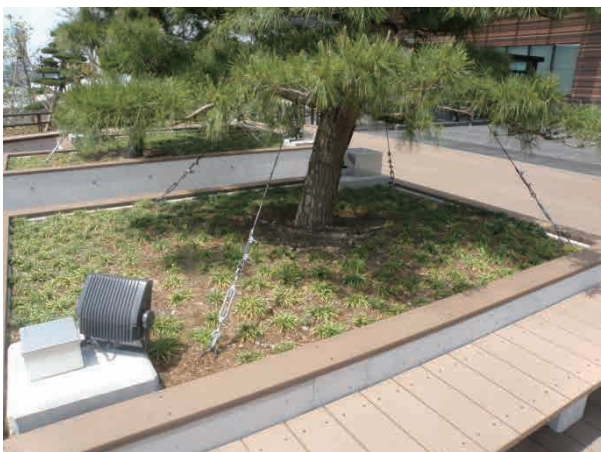
ワイヤー支柱 (首都高速大橋 JC 目黒天空庭園 (東京都目黒区大橋))
