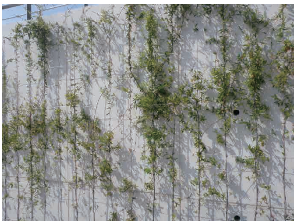
つくばセンタービルノバホール付近の外構 階段横のコンクリート壁面に格子状の金網フェンスを設置し、ツル植物を導入。 (茨城県つくば市吾妻)
