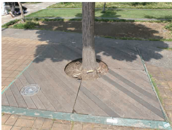
踏圧防止のための根際部の養生 (オルト横浜 (神奈川県横浜市神奈川区))
