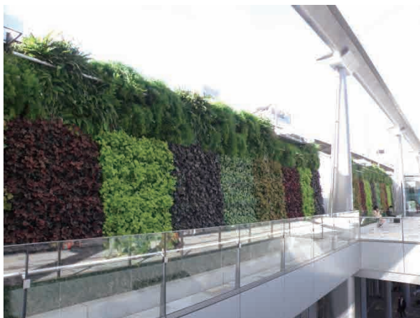
東京駅八重洲口グランルーフ 駅周辺の高層ビルを繋ぐペデストリアンデッキを壁面緑化。ドライミストにより灌水。 (東京都中央区八重洲)
