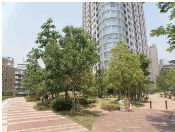
パークコート赤坂 ザ タワー 新築高層マンションの外構を公開空地として緑地 整備。3階にプライベートガーデンの屋上緑化。 (東京都港区赤坂)
