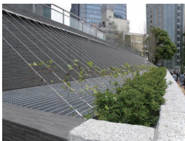
Sola City の外構 公開空地の外構に斜めにワイヤーを張って、ヘデラ類を誘引している。 (東京都千代田区神田駿河台)
