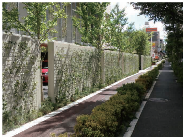
集合住宅敷地外周のコンクリート塀 コンクリートの壁面に格子状の誘引金網を設置し、オオイタビを導入。 (東京都板橋区相生)
