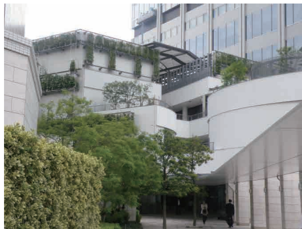
横浜ベイクォーター テラスや外構を中心に樹木を植栽するとともに、緑化パネルを導入してヘデラで壁面緑化。 (神奈川県横浜市神奈川区金港町)
