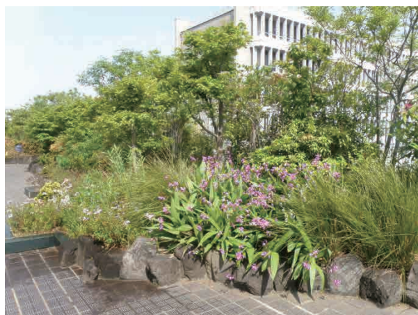
目黒区総合庁舎本館 築40年の既設の本館屋上を全面改修した和風庭園で、屋上緑化の情報基地として整備された。 (東京都目黒区上目黒)
