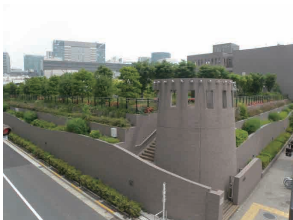
東京都中央卸売市場食肉市場 水処理センター屋上の人工地盤に多様な高木、中低木を組み合わせ、憩いの場を創出。 (東京都品川区北品川)
