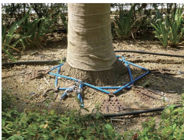
地下支柱 (首都高速大橋 JC 目黒天空の庭 (東京都目黒区大橋))
