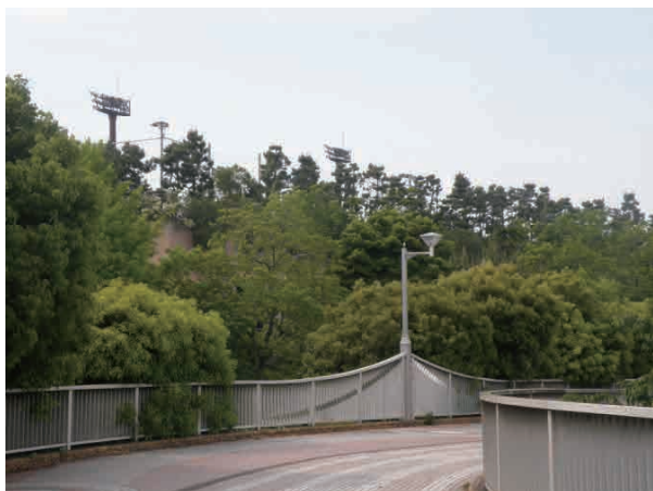
葛西水再生センター 臨海球技場 下水処理施設の上の人工地盤に球技場を作り、クロマツやアキニレなどの高木で緑地を創出。 (東京都江戸川区臨海町)
