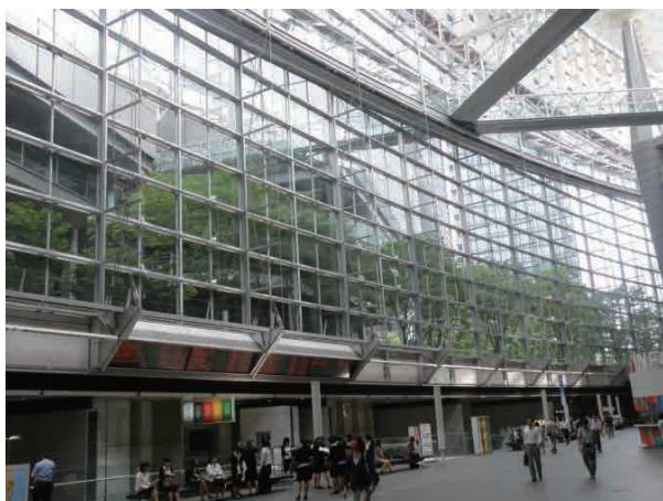
東京国際フォーラム 会議場・展示場周辺の外構の人工地盤上にケヤキの大径木を植栽し緑陰を形成。 (東京都千代田区丸の内)
