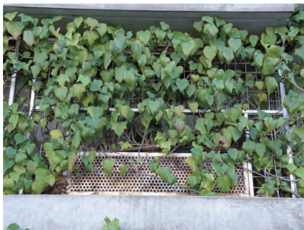
さいたまスーパーアリーナ プランターと灌水設備と登はん補助資材。 (埼玉県さいたま市大宮区)
