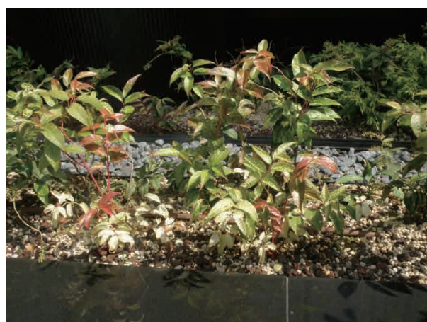
生育基盤一体型の灌水設備 (虎ノ門ファーストガーデン (東京都港区虎ノ門))
