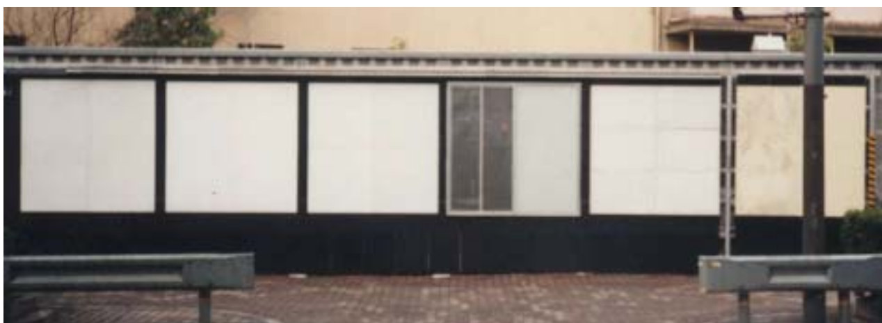
図 5 - 1 建材の設置状況
